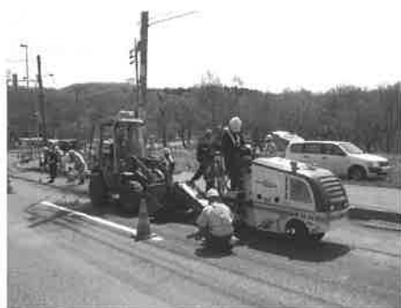
図-7 クラック部溝切削状況
