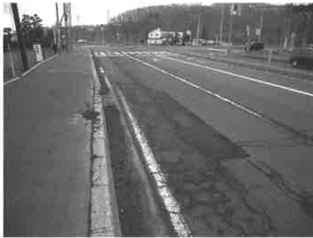
図-11 作業前R側 (2012.3)
