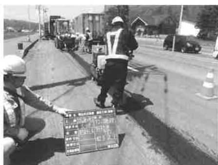
図-9 基層舗装状況
