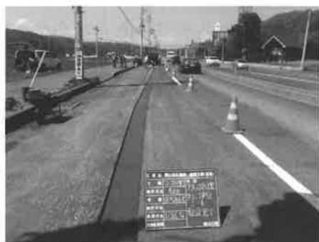
図-8 クラックシート設置状況
