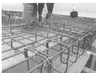
現場の結束作業 (1カ所ずつ手作業) (高所作業の場合もあり)
