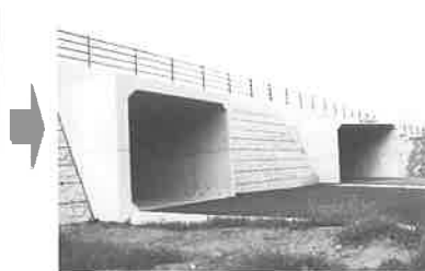
分割式による大型化(上下2分割式の例)
