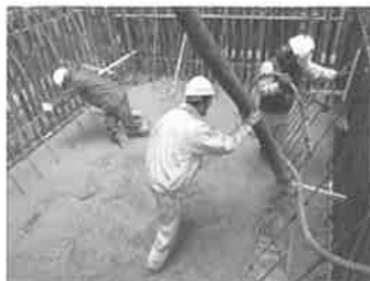
充填不良を防止するための振動締め固め作業
