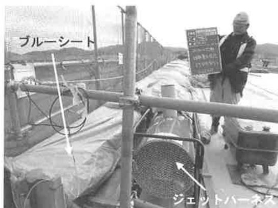
図-4 保温養生状況
