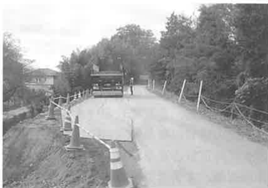
写真-4 搬入用道路
