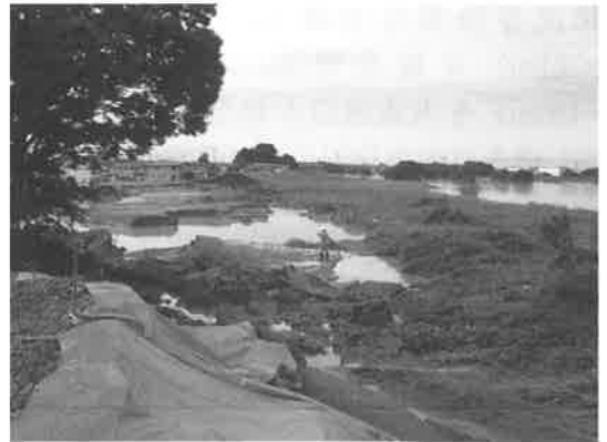
写真－2 鬼怒川堤防決壊状況
