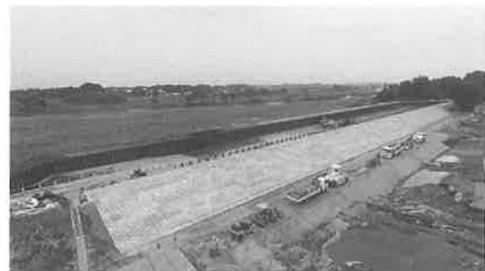
写真-9 仮締切工完了全景（川裏側） 「提供：国土交通省関東地方整備局」
