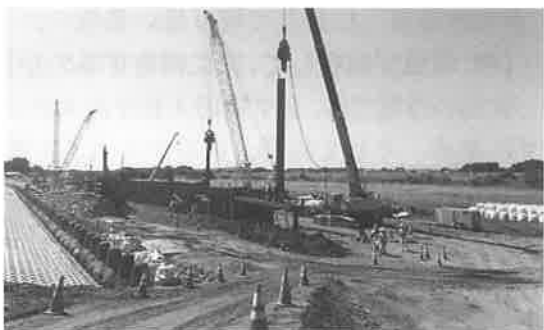
写真-7 二重締切鋼矢板打込状況
