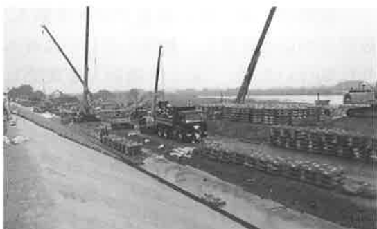
写真-6 連節ブロック仮置状況
