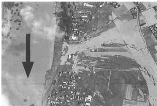
写真－1 鬼怒川堤防決壊状況 「提供：国土交通省関東地方整備局」
