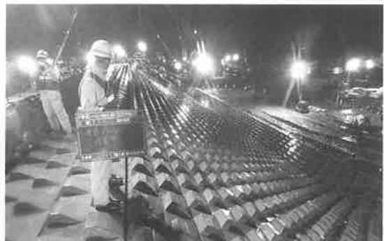
写真-8 荒堤防完成状況
