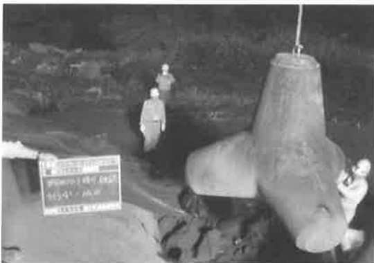
写真-5 根固めブロック投入状況
