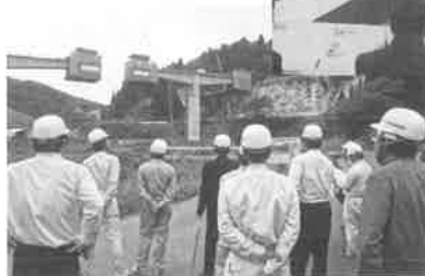
現場視察研修「利賀ダム工事現場」
