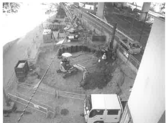
図-2 中央分離帯での施工状況
