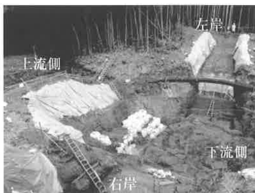
写真-2 地滑り箇所復旧完了
