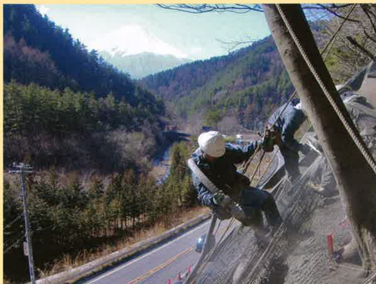
撮影地：富士河口湖町 工事内容：落石防止工事（法粹工） 時間帯：午前10時頃 富士山をバックに撮影できたので投稿しました。
