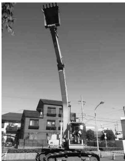
重機体験 1（バックホー）
