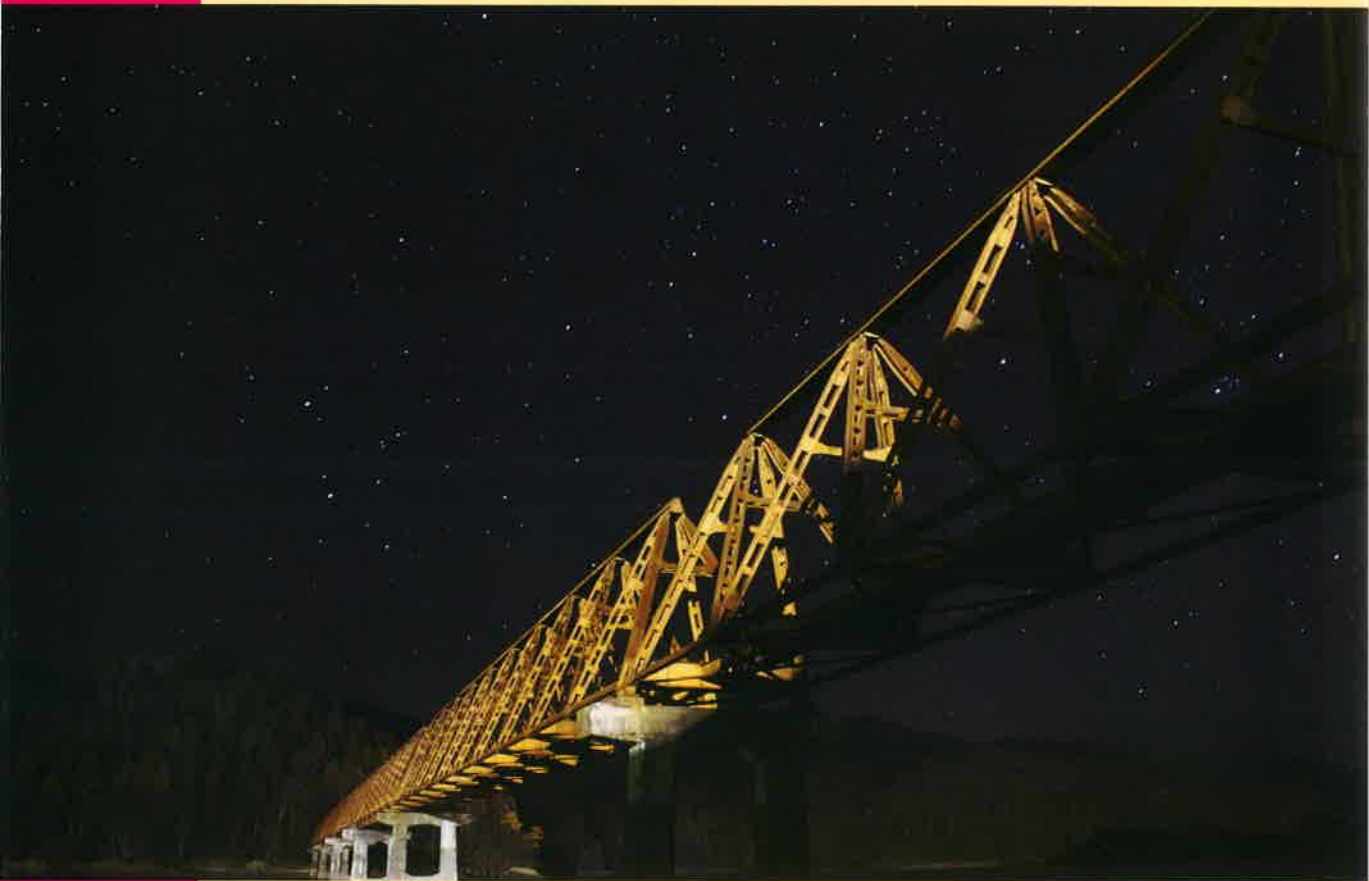
第一回土木工事写真コンテスト優秀賞受賞作品「ダム湖に沈む三弦橋」 平田 学 様
