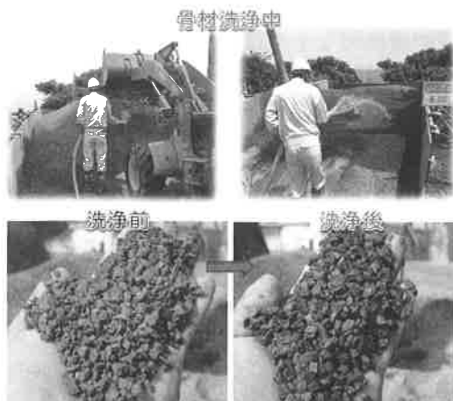
図－7 骨材洗浄状況
