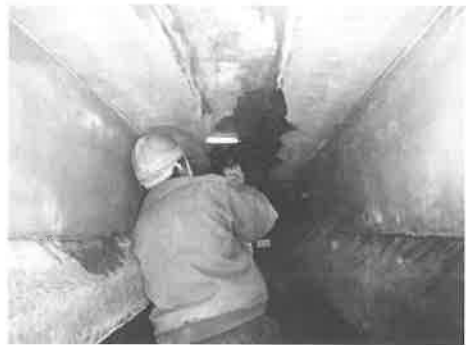
図-8 表面被覆工
