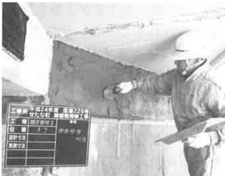
図-6 断面補修工（左官作業）
