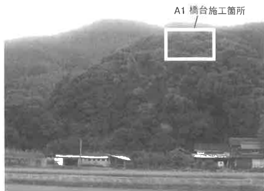
図-1 施工箇所写真
