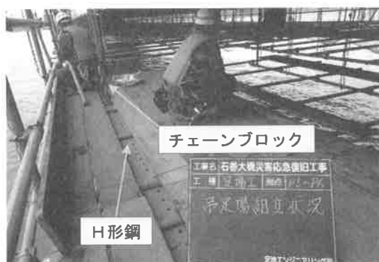
図-4 H形鋼を利用した吊足場設置状況
