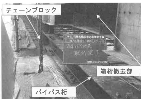
図-6 バイパス桁設置と損傷部撤去状況
