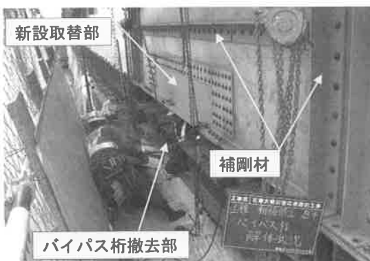
図-7 バイパス桁撤去状況①
