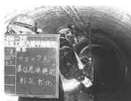
図－２ 注入孔削孔状況
