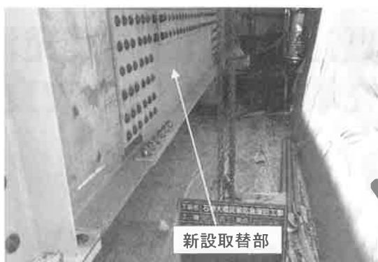
図－9 損傷部への新設部材設置完了
