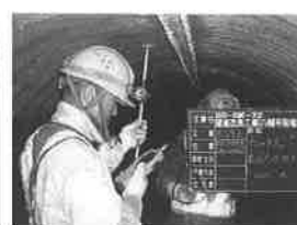
図－３ 内視鏡による 充填確認
