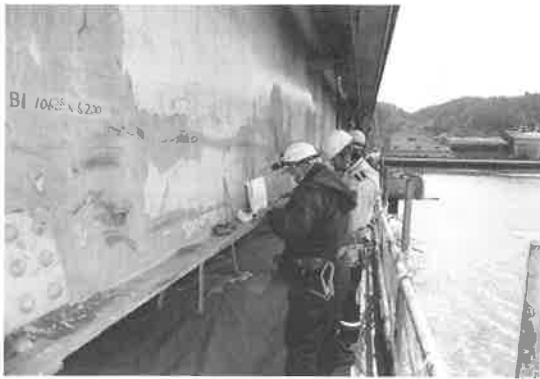
図ー2 主桁損傷の調査状況
