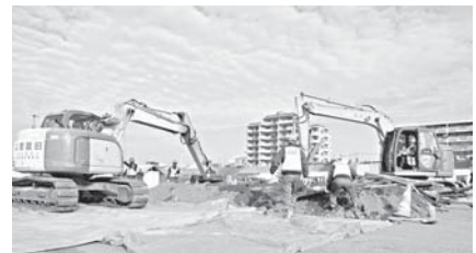
道路啓開訓練②
