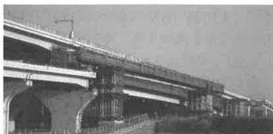
図-5 三宅IC橋／OFFランプ縦取り架設状況
