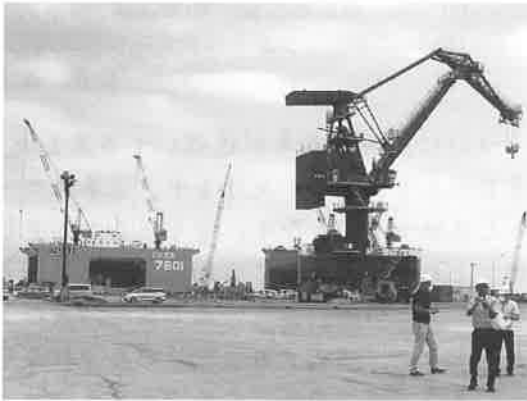
ケーソン台船とクレーン（相馬港）
