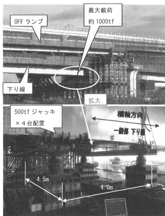
図－6 反力管理用ジャッキ配置状況
