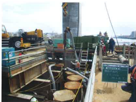
エアーリフト施工状況
