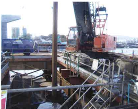
アースドリル施工状況
