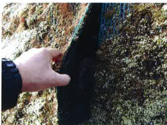
コケの植生基盤の流亡抑制の 目的で立体マットを使用
