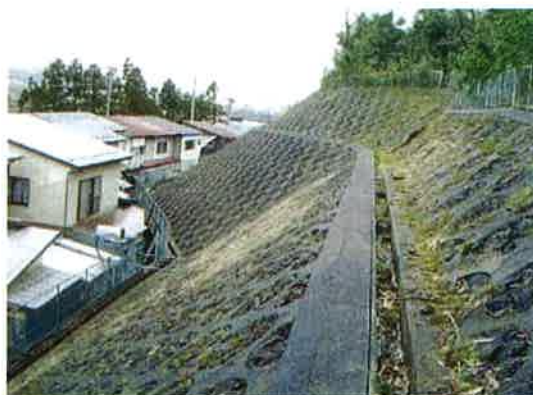
空石積みプレキャスト枠工
