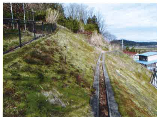
コケ緑化施工（施工後7年経過）
