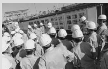
現場 14 新相生橋上部工事②(全体説明)
