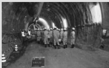
現場 8 芳ノ元トンネル工事②
