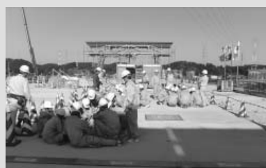
現場 15 新相生橋上部工事③(鉄筋結束作業説明)
