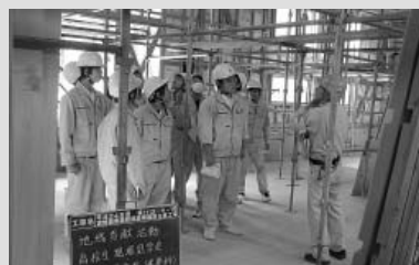
現場2 宮崎商業高校武道場建設工事②
