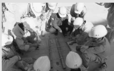
現場 16 新相生橋上部工事④(鉄筋結束作業実技)
