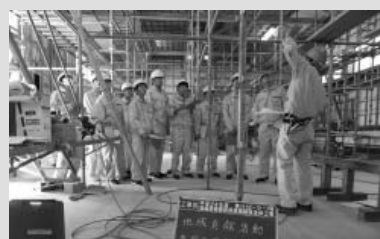
現場6 宮崎商業高校武道場建設主体工事
