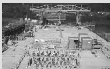
現場 17 新相生橋上部工事⑤(記念撮影)
