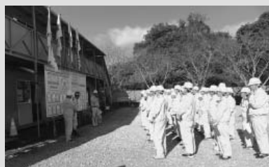
現場3 児湯るびなす校舎棟建設主体工事①
