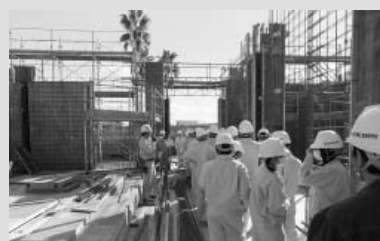
現場5 児湯るびなす校舎棟建設主体工事③
