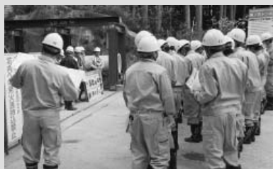
現場 7 芳ノ元トンネル工事①
