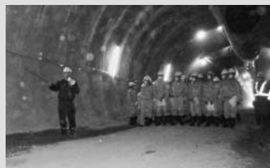
現場 9 芳ノ元トンネル工事③
