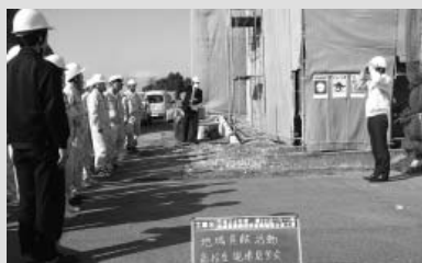
現場1 宮崎商業高校武道場建設工事①
