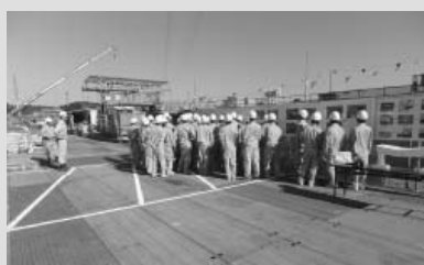
現場 13 新相生橋上部工事①(全体説明)
