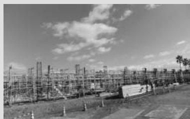
現場4 児湯るびなす校舎棟建設主体工事②
