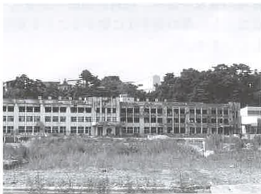
写真－2 石巻門脇小学校 火災被災跡
