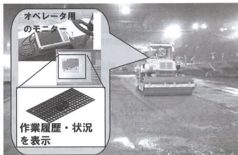
図4 TS・GNSS締固め
