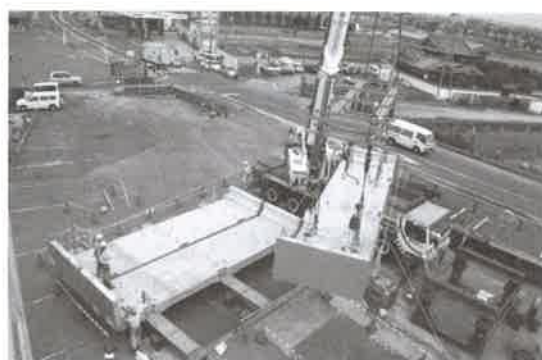
図-12 架設状況 (模擬訓練)
