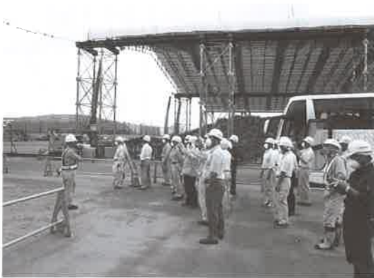
写真－4 石巻廃棄物処理現場 1
