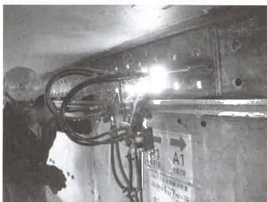
図-4 ガス切断状況
