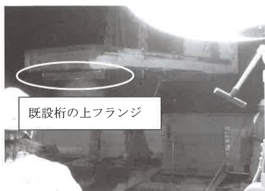
図-6 既設床版の撤去状況
