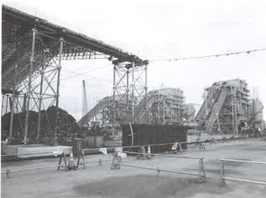
写真－5 石巻廃棄物処理現場 2
