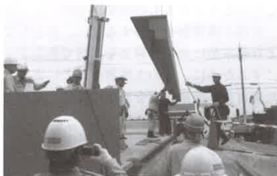
図-13 仮設鋼床版架設 (模擬訓練)
