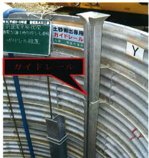
ガイドレール取付状況
