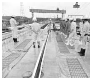
橋梁上部工工事②
