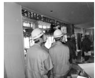
増改築工事②
