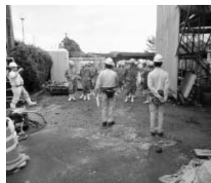
増改築工事①
