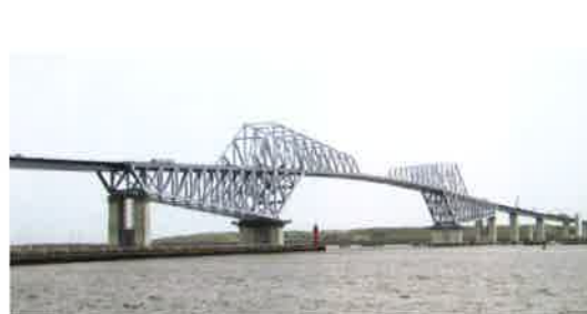
図－６ 架設完了後の全景
