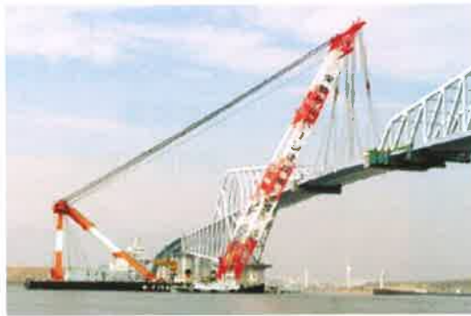
図－４ 併合部箱桁の大ブロック架設（側面）
