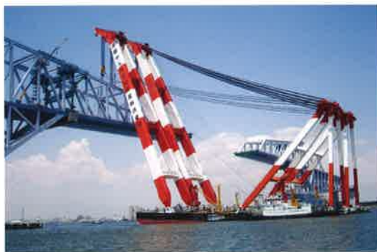
図－３ トラス部大ブロック架設
