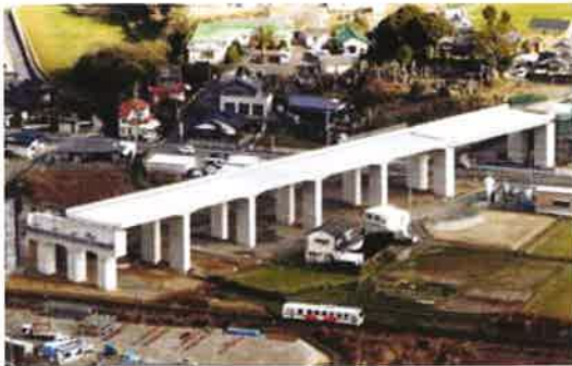
工事区間全景
