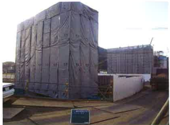
躯体全体養生状況（冬季）
