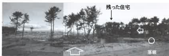
写真-2 津波後（4/30）の裏法先の状況
