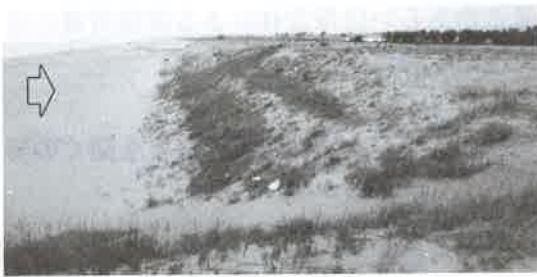
写真-6 盛土の表法 (7/9)
