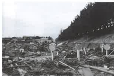
津波被害状況② （仙台市東部道路際）
