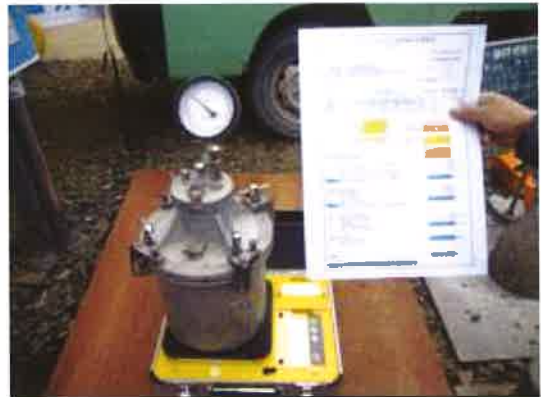
単位水量測定状況（エアメータ法）
