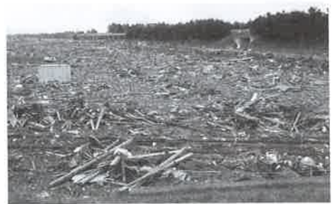
写真-8 山側の状況：4/30
