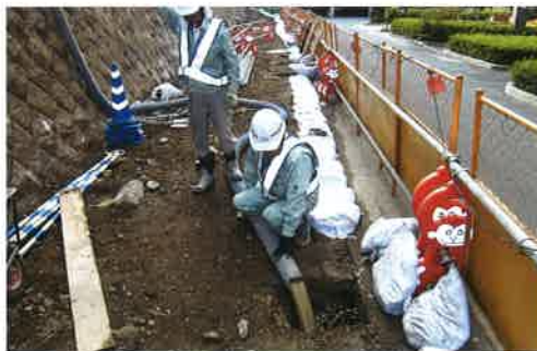
流動化処理土流入状況
