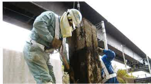
付着土撤去状況
