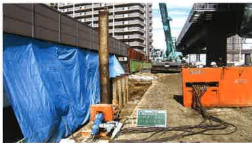
パイルプラー及び引抜き状況
