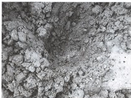
写真-10 壁面Aコンクリート 内部に浮上水分はなし
