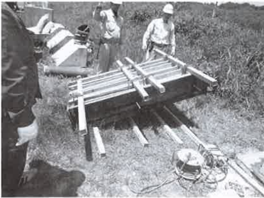
写真-7 生コン打設型枠転倒中 単位水量測定のため型枠転倒。
