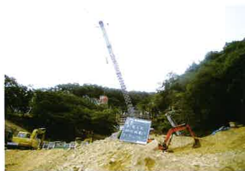
起伏装置付きケーブルクレーン
