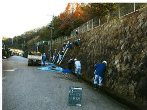
現場付近清掃
