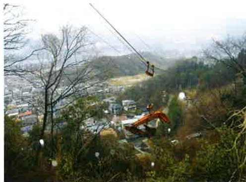
着工前現場付近
