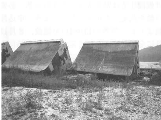
6 山田町舟越地区 堤防
