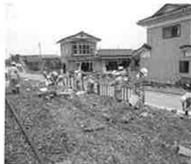
人力での瓦礫撤去
