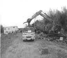
重機を使用した瓦礫撤去
