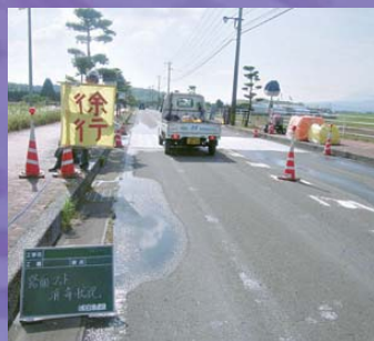
口蹄疫消毒ポイント(マット設置)
