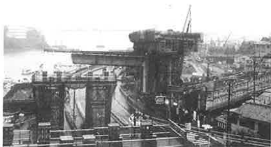
図－9 旋回横取り施工前
