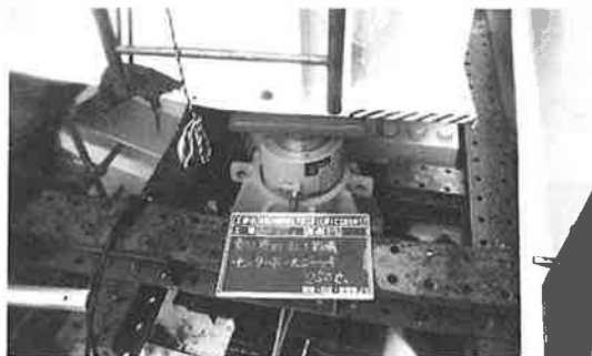
図－8 91旋回芯250tセンターホールジャッキ
