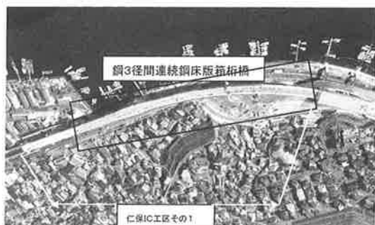
図-2 工事施工範囲航空写真全景
