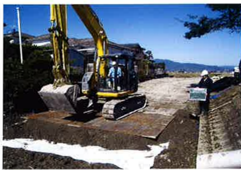
試験施工状況写真
