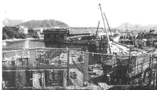
図－10 旋回横取り施工完了
