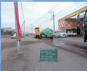
降灰除去(散水)作業5
