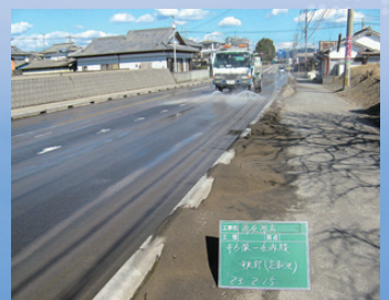
降灰除去(散水)作業4
