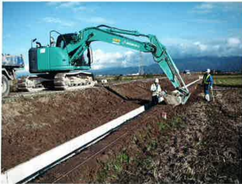
図ー１ 対策前施工状況
