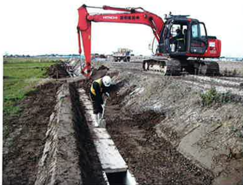
図ー３ 合板足場板を使用した作業状況
