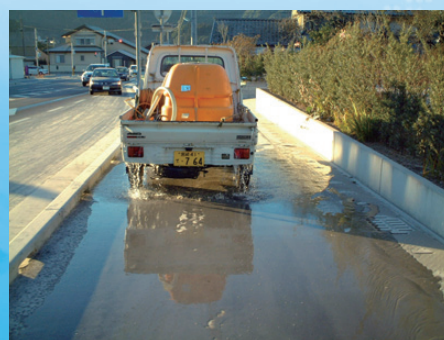
降灰除去散水作業(1)
