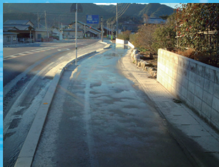
降灰除去散水作業(2)
