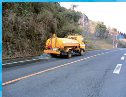
降灰除去散水作業(3)
