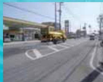
路面散水処理②
