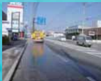
路面散水処理①
