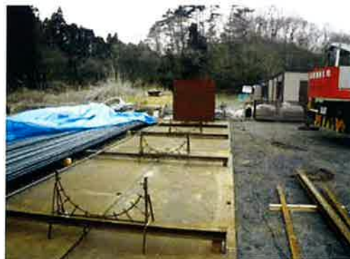
図－４ 杭鉄筋の組立定規
