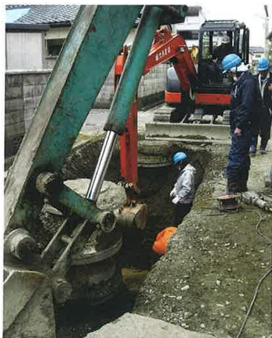
福島市森合地内の水道管復旧
