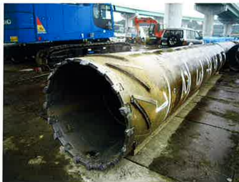
図－２ t = 20\text{mm} の鉄板を溶接して掘削径を +40\text{mm} とする
