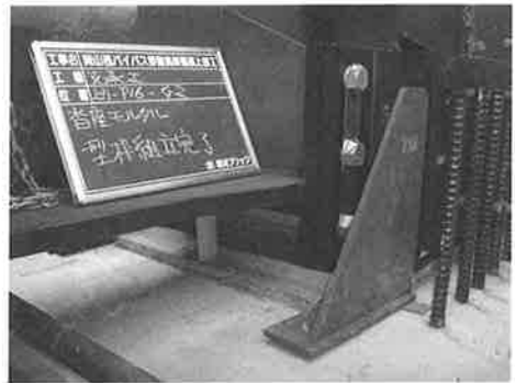
写真－4 バッファ固定金具取付位置
