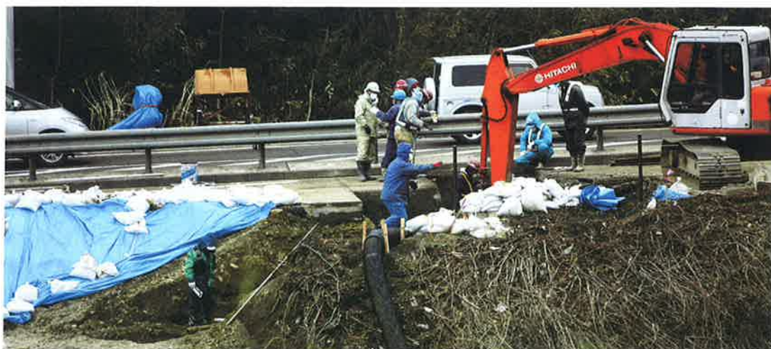
福島市伏拝地内の水道管復旧
