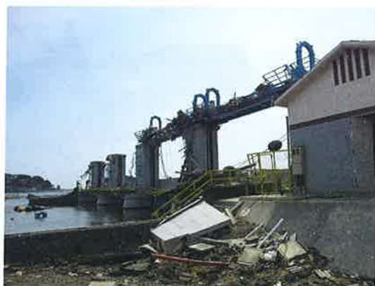
本吉郡南三陸町の防潮水門
