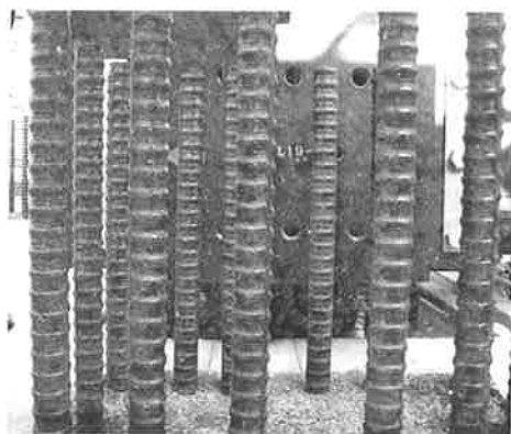
写真-1 鉛直鉄筋とアンカーボルトの干渉
