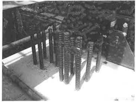
写真－3 バッファ固定金具（赤いプレート）
