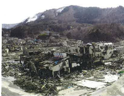
牡鹿郡女川町の建物群
