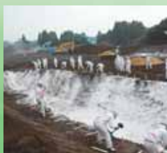
6.17 佐土原 掘削等作業
