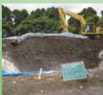
6.11-12 跡江 埋設シート布設作業
