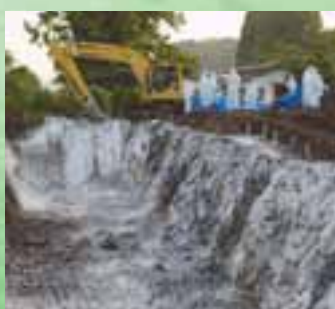
6.11-12 跡江 掘削・消石灰布設作業
