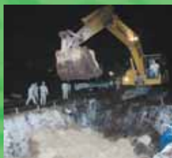
7.4-5 跡江 埋却・埋設作業(敷薬)
