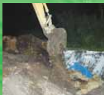
7.4-5 跡江 埋設作業(覆土)
