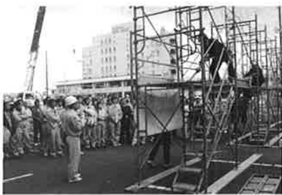
写真-1 手すり先行足場の実演講習
