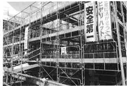
写真-2 手すり先行足場施工の例
