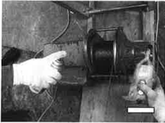
瓦上げ機の確認をする
