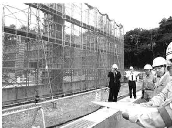
写真-4 現場パトロール
