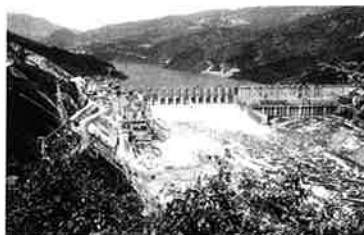
写真一 6 水口ダム
