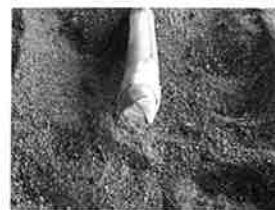
ウエスを詰め込み、その上からテープを巻く
