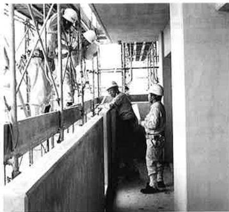
建災防大分県支部安全パトロール
