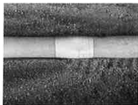
穴あけ箇所テープを巻く
