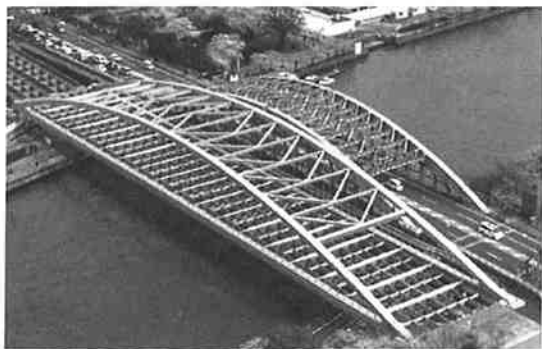
写真-1 架設完了時の全景
