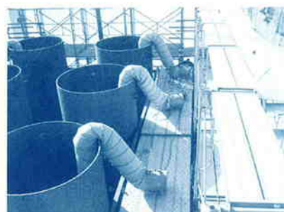
写真-1 エアークーリングの実施状況
