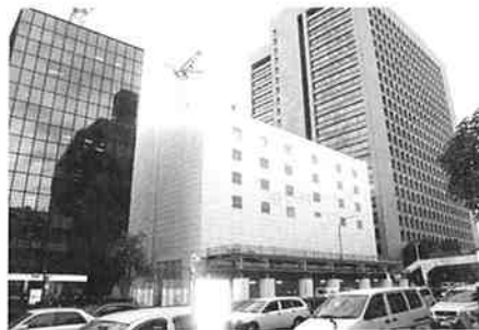
写真—1 建物全景（解体前、解体中）
