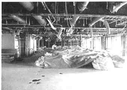
写真-4 石綿除去後
