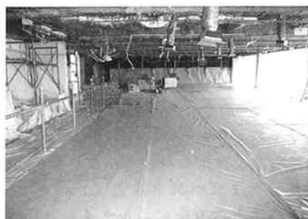
写真-2 石綿除去前養生
