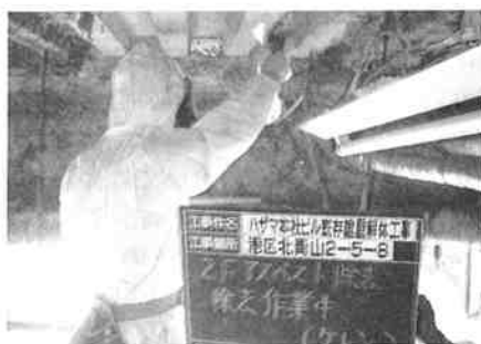
写真-3 石綿除去
