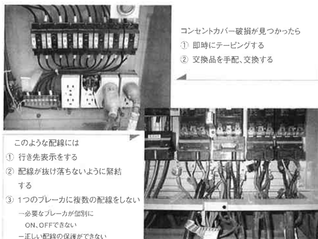
図-16 分電盤の点検項目図例
