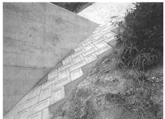
写真-2 補修完成
