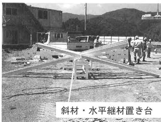
写真-7 斜材・水平継材置き台
