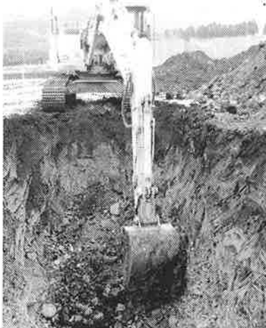
埋却溝は深さ4-5mを要した (写真提供・宮崎県)
