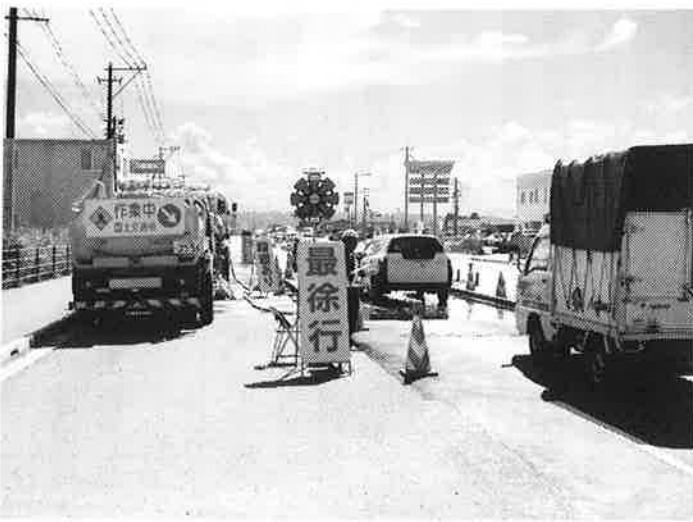
車両を消毒作業中の国道10号線（8月25日）。家畜の殺処分が終わっても建設業の活動は続いていた
